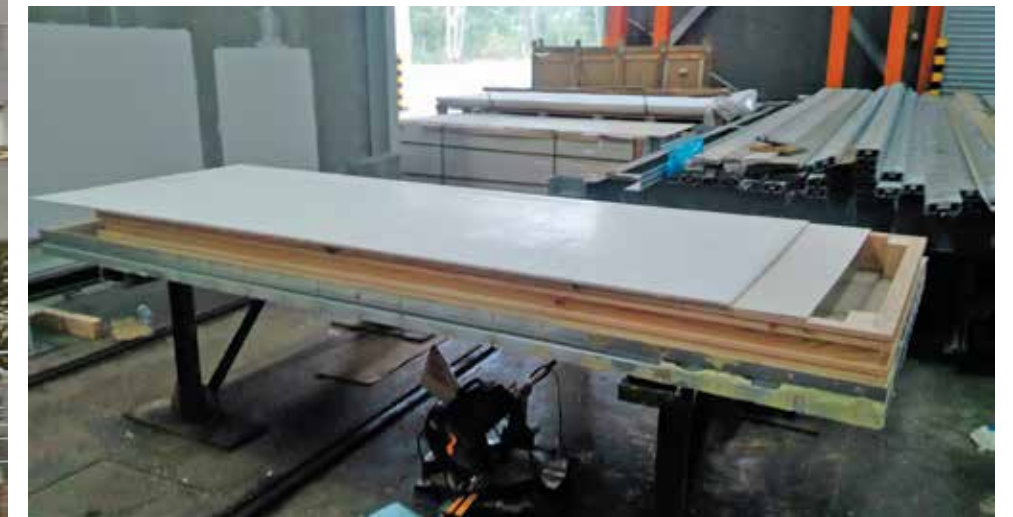
Construção de protótipo do painel modular (fonte: Electrofer).
