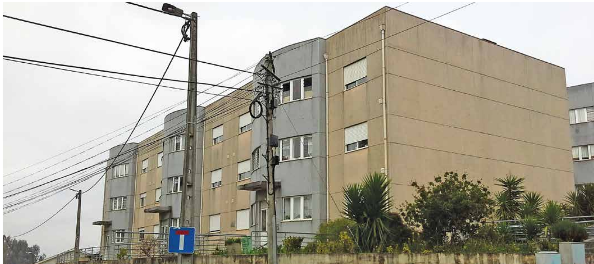
Edifício piloto (gerido pela Gaiurb) (fonte: Electrofer).
