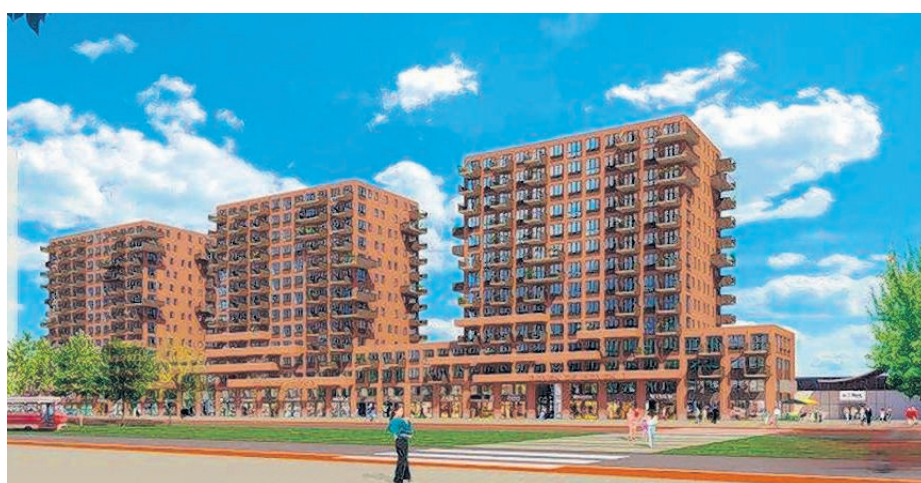
■ Webo levert de gevels met kozijnen voor drie woontorens in Delft. De gebouwen worden dankzij innovatie uit Rijssen neergezet zonder dat er een steiger aan te pas komt.
